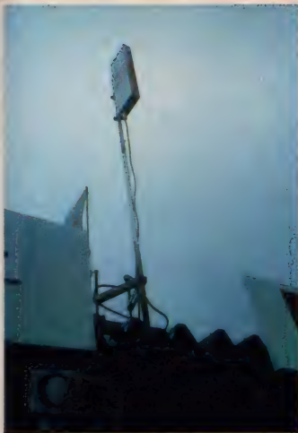
●(写真2)システムには、システム側、コース側に各1人が配置されるようになっている。 ●赤外線受光器はピットの屋根の上に取り付けられる。
